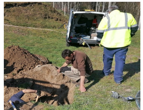
Ci-dessus Noël Hamon et les techniciens d'Arche Agglo interviennent sur la canalisation endommagée.
